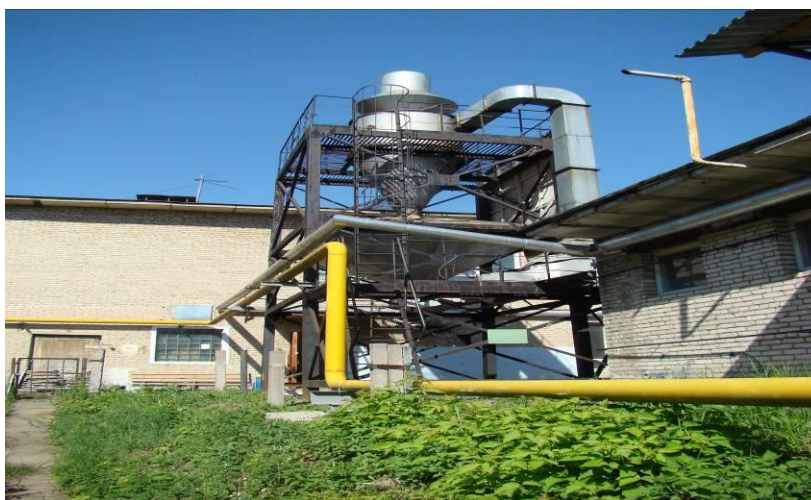
Пылеулавливающая установка от деревообрабатывающих станков
