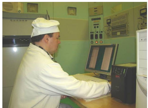
Центральный дозиметрический пульт системы радиационного контроля
