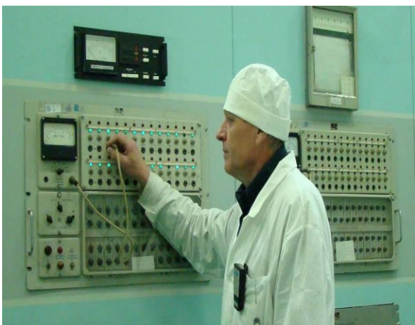
Центральный дозиметрический пульт системы радиационного контроля
