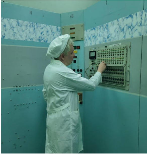
Центральный дозиметрический пульт системы радиационного контроля
